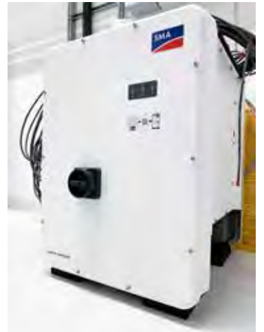
Blick auf den Hauptstandort mit einem Teil der neuen Photovoltaikanlage auf der Halle 4, PV-Wechselrichter für die Umwandlung des Gleichstroms in Wechselstrom
