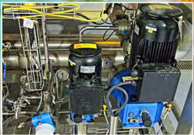
sera Mehrlagenmembranpumpen sorgen in einer Anlage unseres Partners Centec für präzise Dosierung
