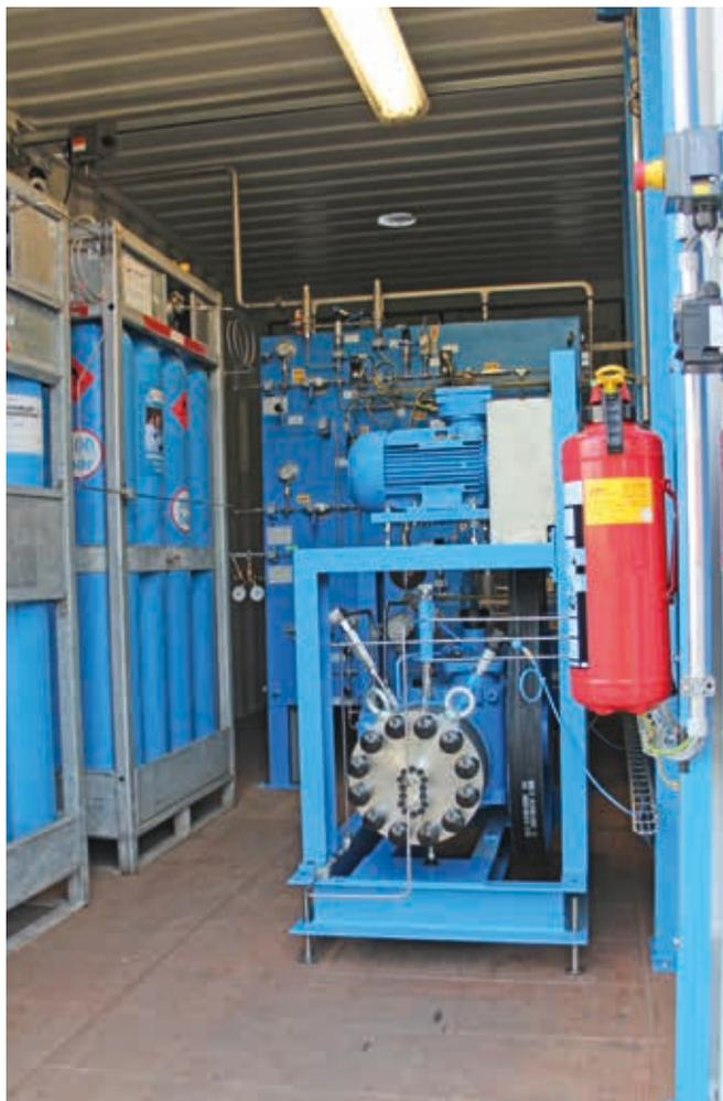
Standard Kompaktmembranverdichter mit Flaschenbündeln
