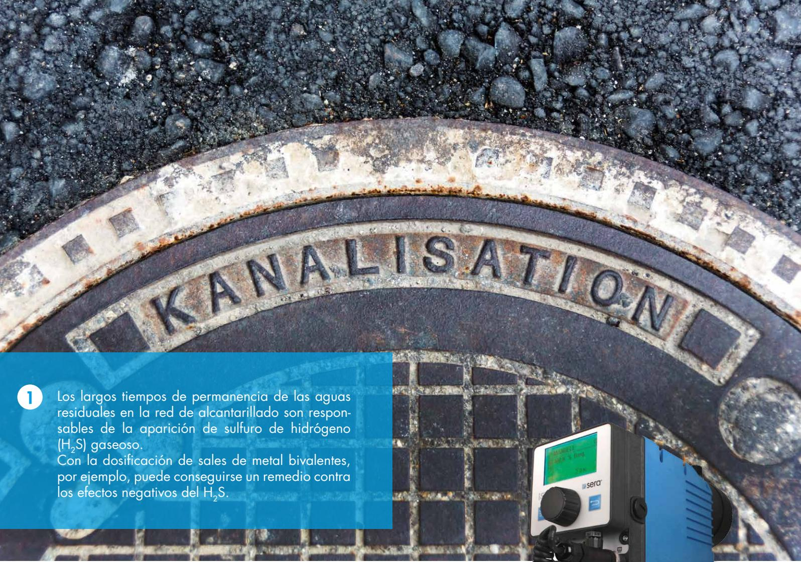
1 Los largos tiempos de permanencia de las aguas residuales en la red de alcantarillado son responsables de la aparición de sulfuro de hidrógeno ( $H_2S$ ) gaseoso. Con la dosificación de sales de metal bivalentes, por ejemplo, puede conseguirse un remedio contra los efectos negativos del  $H_2S$ .
