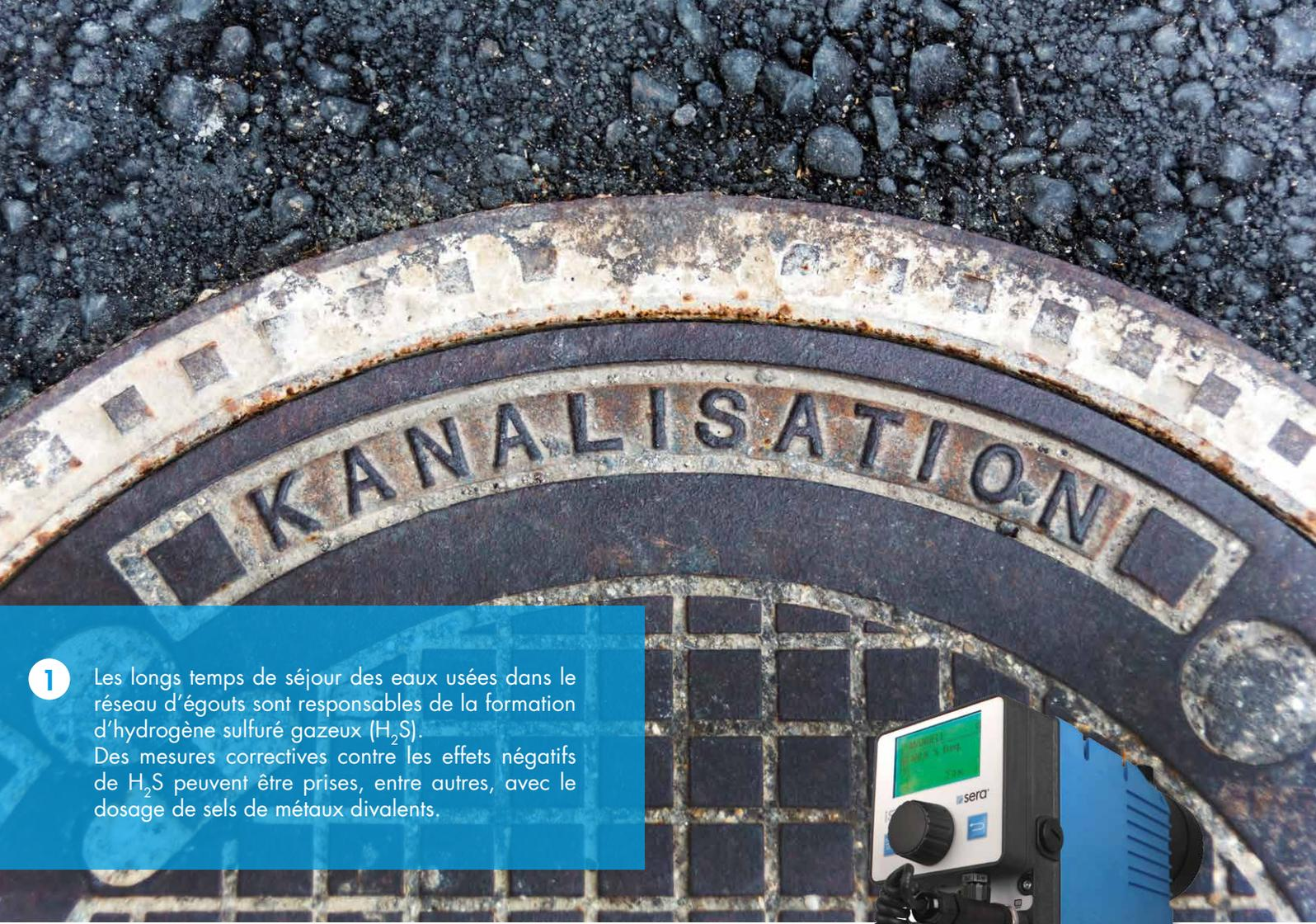
1 Les longs temps de séjour des eaux usées dans le réseau d'égouts sont responsables de la formation d'hydrogène sulfuré gazeux (H<sub>2</sub>S). Des mesures correctives contre les effets négatifs de H<sub>2</sub>S peuvent être prises, entre autres, avec le dosage de sels de métaux divalents.
